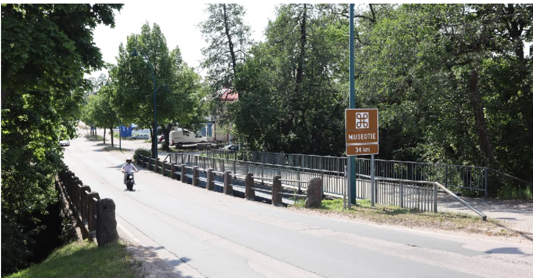
Kuva 4. Virojoen yltävä kiviholvisilta. (Valokuva: Kaija Maunula, 2023)
