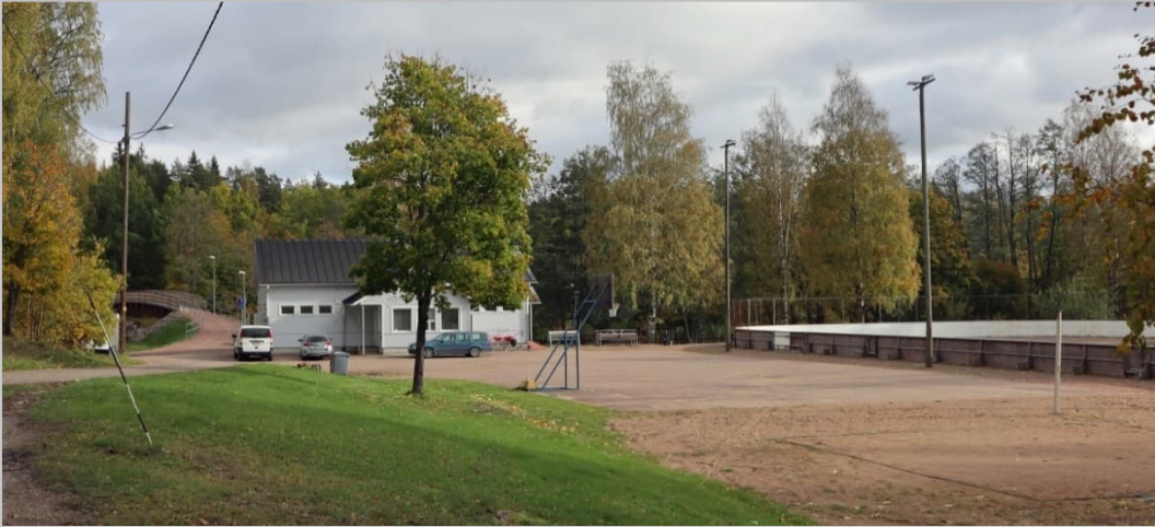
Kuva 1. Suunnittelualue lännestä päin kuvattuna. Vasemmalla kunnan huoltorakennus, oikealla jääkiekkokaukalo. Vasemmalla taustalla Virojoen ylittävä kevyen liikenteen silta. (Valokuva: Kaija Maunula, 2023)
