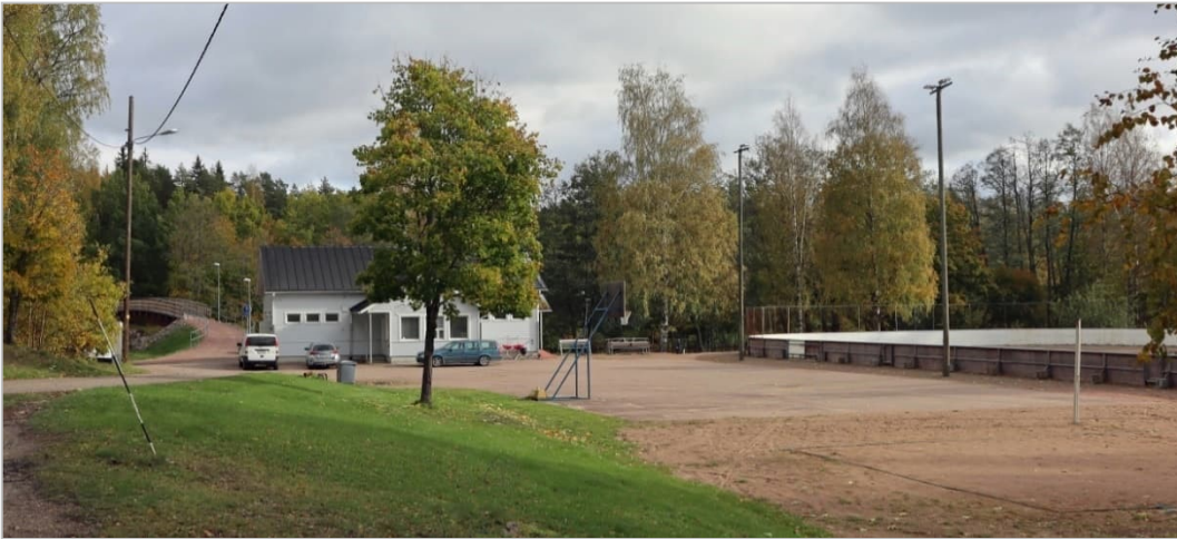
Kuva 1. Suunnitteluala lännessä päin kuvattuna. Vasemmalla kunnan huoltorakennus, oikealla jääkiekkokaukalo. Vasemmalla taustalla Virojoen ylittävä kevyen liikenteen silta. (Valokuva: Kaija Maunula, 2023)
