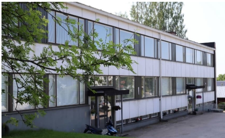
Kuva 29. Asuinkerrostalo, Louhelantie 1. (Valokuva: Kaija Maunula, 2023)
