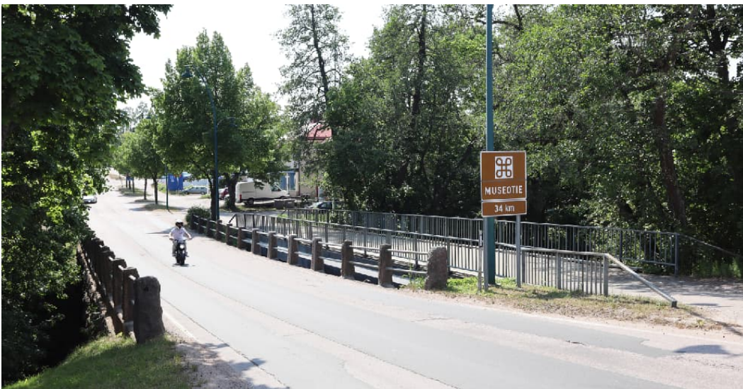
Kuva 4. Virojoen ylittävä kiviholvisilta. (Valokuva: Kaija Maunula, 2023)
